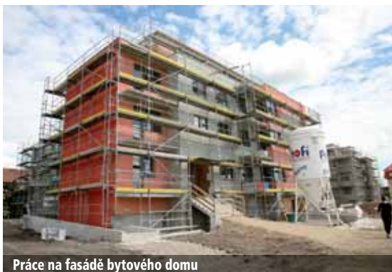
Práce na fasádě bytového domu
