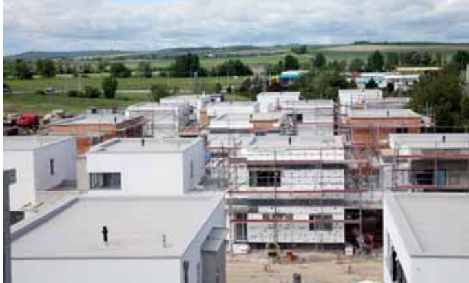
Pohled na staveniště z bytového domu
