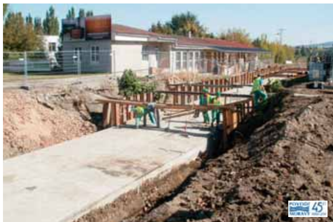
Pohled před betonáží rámového propustku a po dokončení a zastropení archiv Povodí Moravy
