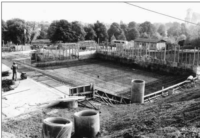
Armování dna budoucího bazénu.
