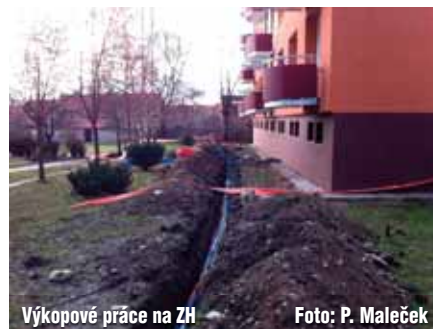
Výkopové práce na ZH
